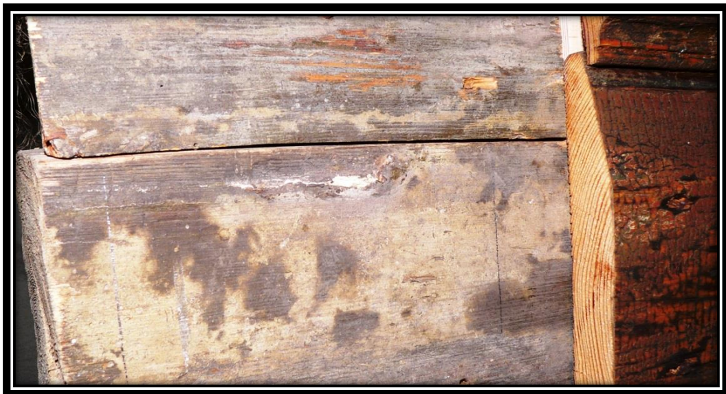
Nama fasādes fragments, atsegta guļbūve, redzams: fasādes oriģinālais krāsojums pernica un gaiši zila eļļas krāsa un vēlāko laiku fasādes dēļu apšuvums. 2014.gads.
