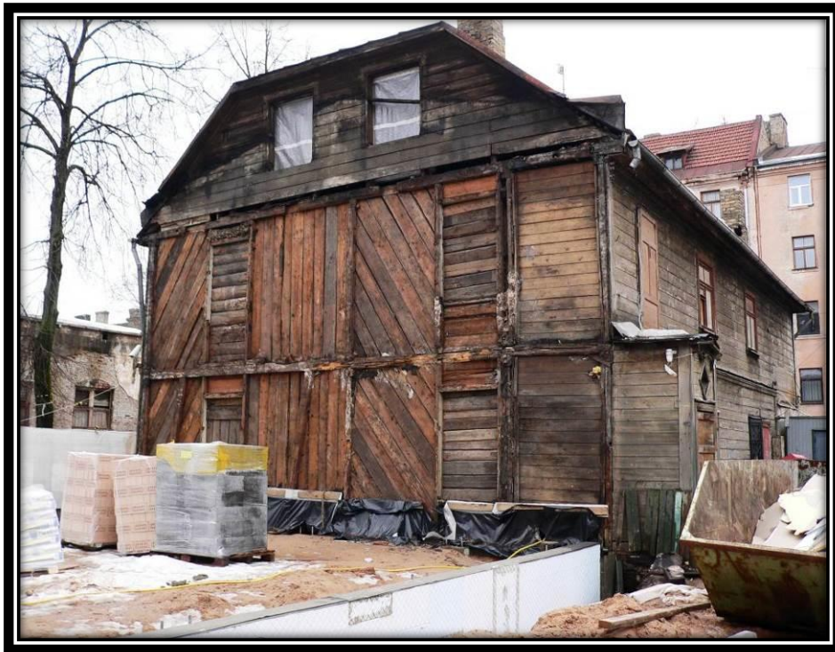
Krāsotāju ielā Nr.12, renovētās ēkas pamati. 2011. gads.
