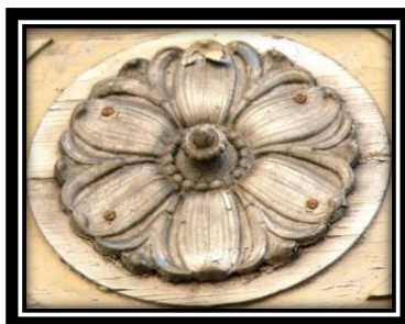
Zemesgabala Puškina ielā Nr.4, Gr.41/108. apbūve
