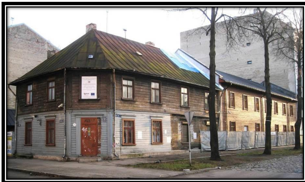
Krāsotāju ielā Nr.12, renovēta otrā korpusa būve. 2011. gada 11. novembris
