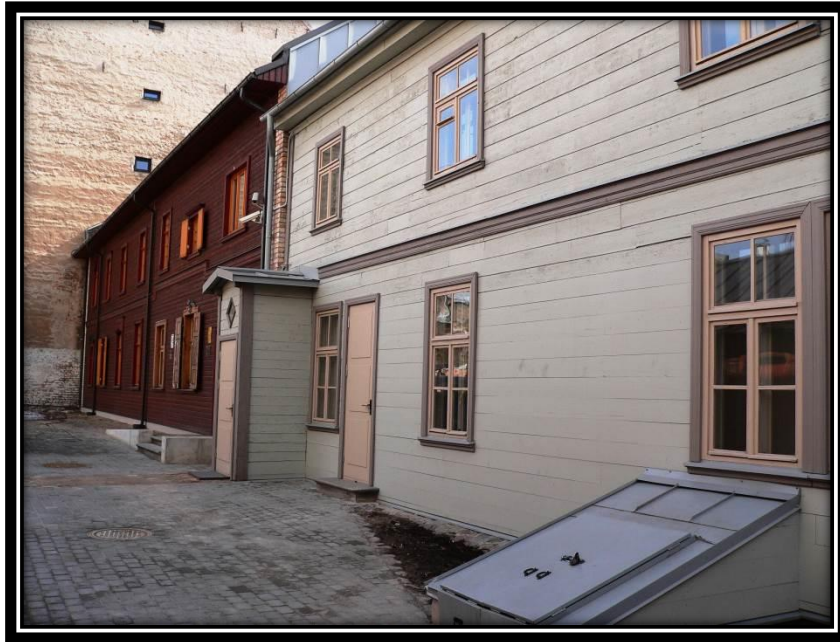
Ēka Krāsotāju ielā Nr.12, būvēta 1876.gadā, arhitekts Heinrihs Geigenmīllers, tumšais korpuss būvēts 1895.gadā, arhitekts Konstantīns Pēkšēns. Renovācijas projekts 2009.gadā, arhitekts Mikus Lejnieks. Skats no pagalma. 2013. gads.
