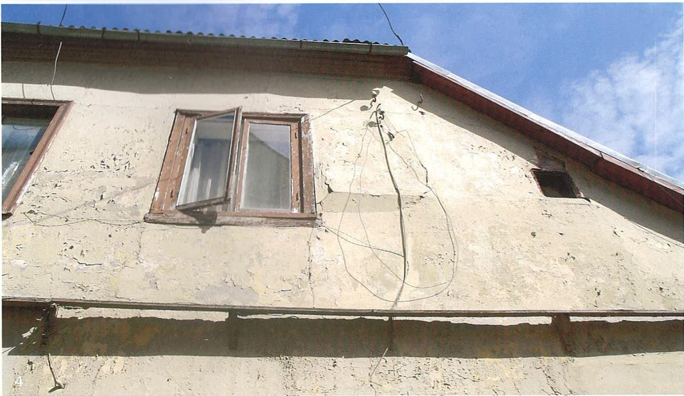
Raksturīgas plāsas ēkas zelmiņa daļā norāda, ka zem apmetuma ir pildrežģis (fahverks) un tas sācis nedaudz deformēties. Nav nekas traģisks, bet iemeslus derētu noskaidrot.
